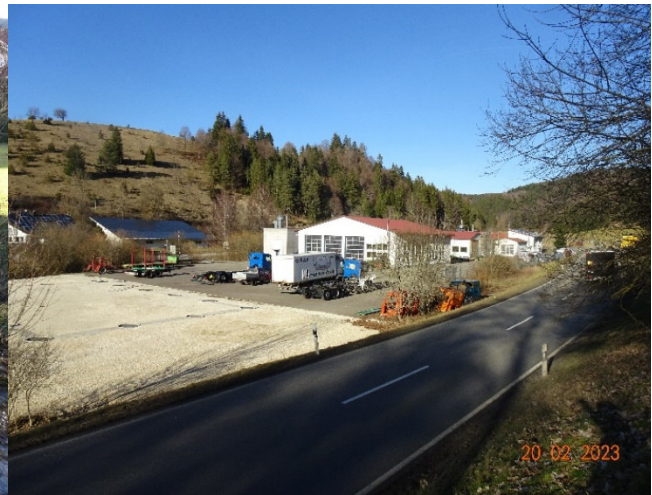
Foto 6: Bestehendes Firmenareal mit Gebäude und Hofflächen
