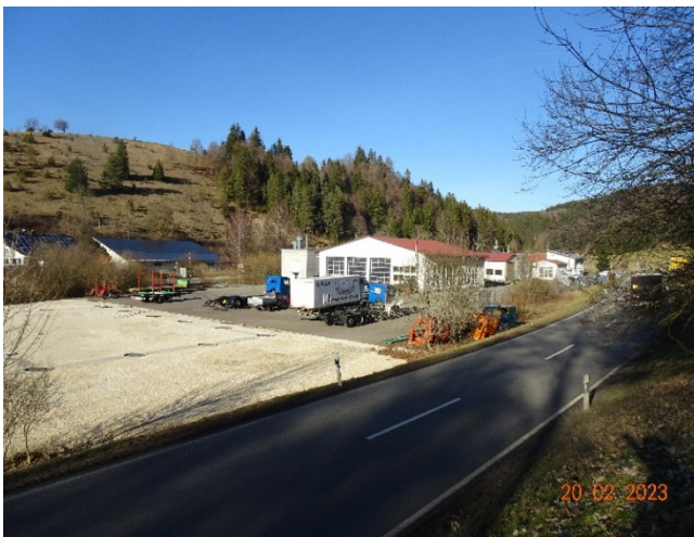
Foto 9: Bestehendes Firmenareal mit Gebäude und Hofflächen Blickrichtung Osten
