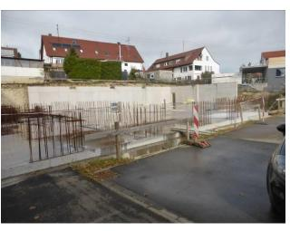
Foto 10: Betonierte Bodenplatte des Erweiterungsbaus
