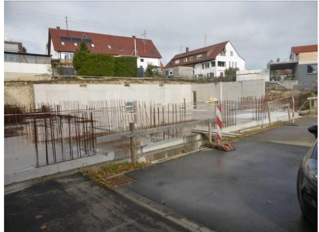
**Foto 10:** Betonierte Bodenplatte des Erweiterungsbaus
