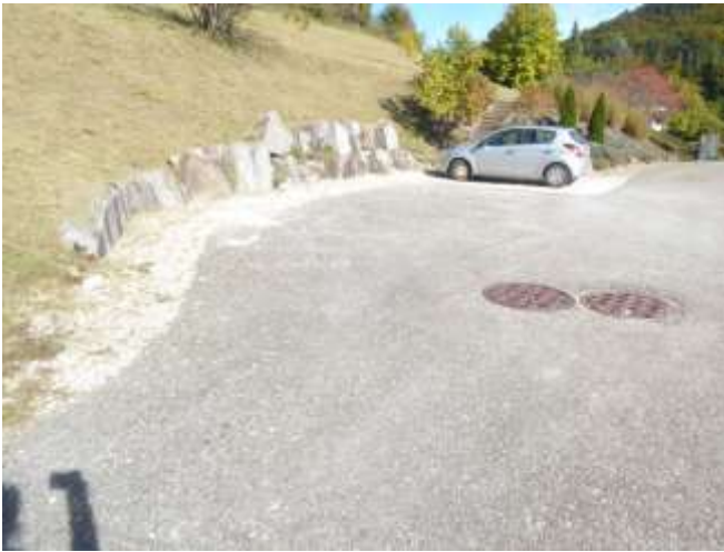
Foto 3: Wendeplatte am Ende der Straße
