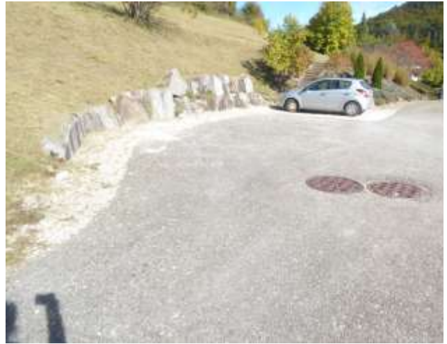
Foto 2: Steinmauer an Wendeplatte am Ende der Straße „An der Bitterhalde“ mit Blick nach Nordosten
