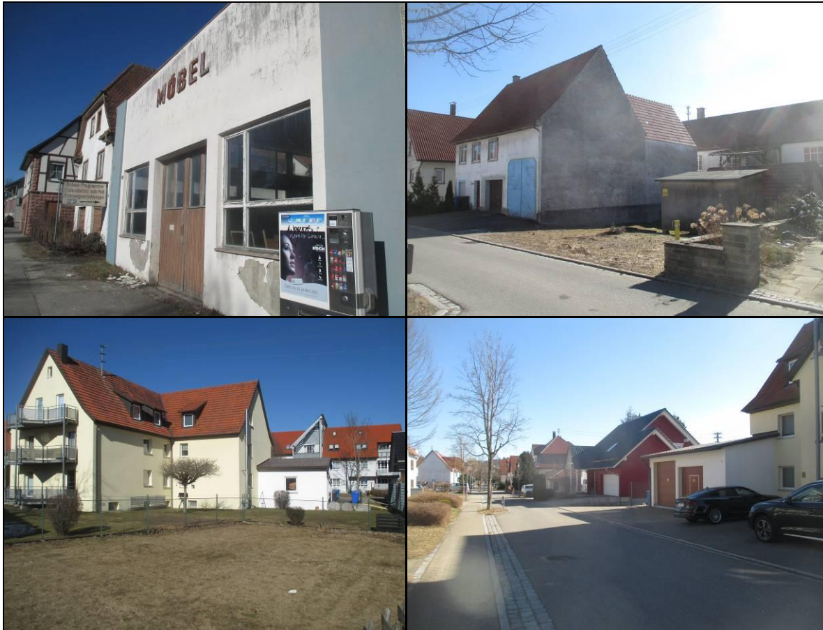
Abbildung 3 Gebäude westlich der Lindenstraße: Alte Möbelfabrik (oben links Vorderansicht, oben rechts Hinteransicht mit Bauernhaus), Mehrfamilienhaus am Westende des Plangebiets (unten links), Blick entlang der Kirchstraße (unten rechts).
