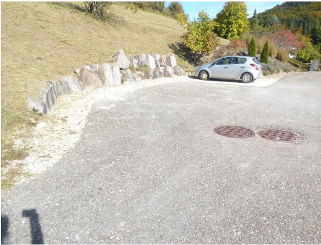
Foto 3: Wendeplatte am Ende der Straße
