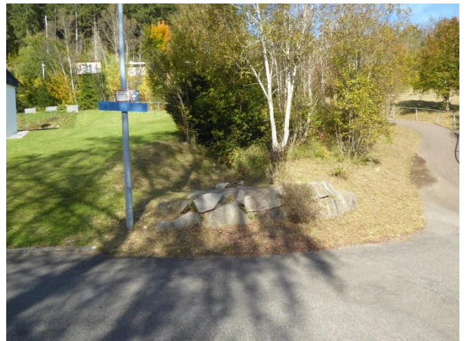
Foto 6: Graben unmittelbar vor Eintritt in die Verdolung im Bereich der Straße „An der Bitterhalde“ und südlicher Rand der Gehölzpflanzung
