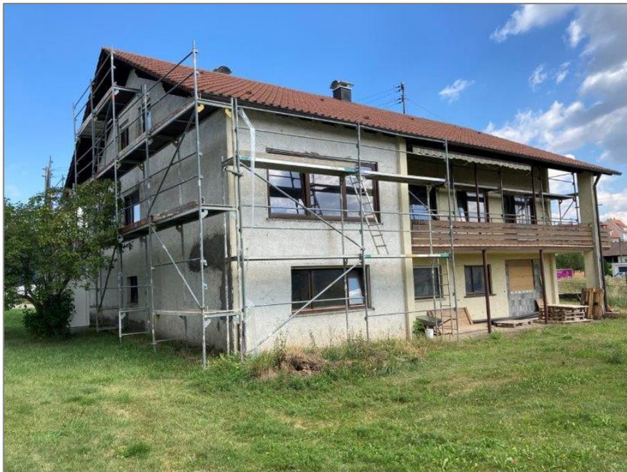
**Abb.4:** Eingerüstetes, derzeit saniertes Wohnhaus
